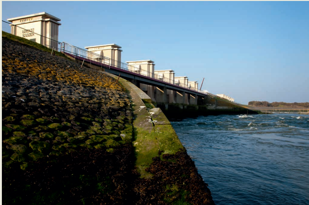
© Siebe Swart / HH - spuisluisen Kornwerderzand
